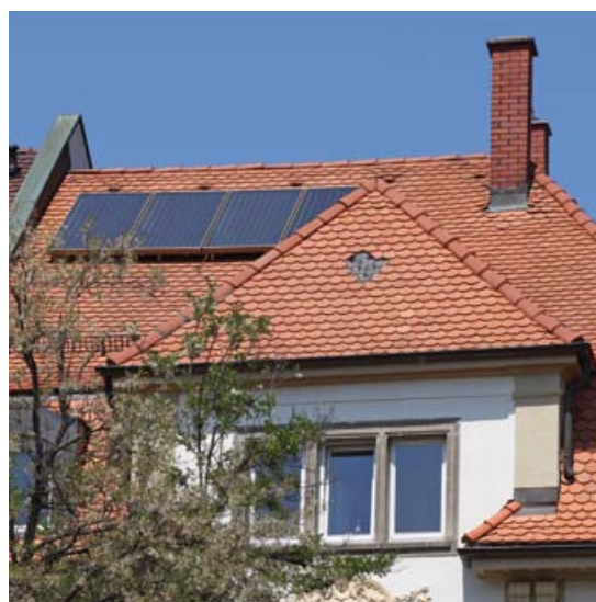
von links: Straßenfassade mit Stuckornamenten Neu integrierter Aufzug im ehemaligen Innenhof Detail der Dachsanierung, Solaranlage
